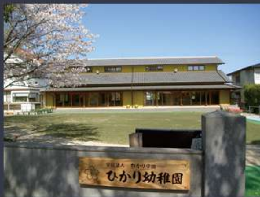
学校法人ひかり学園 ひかり幼稚園 改修工事
