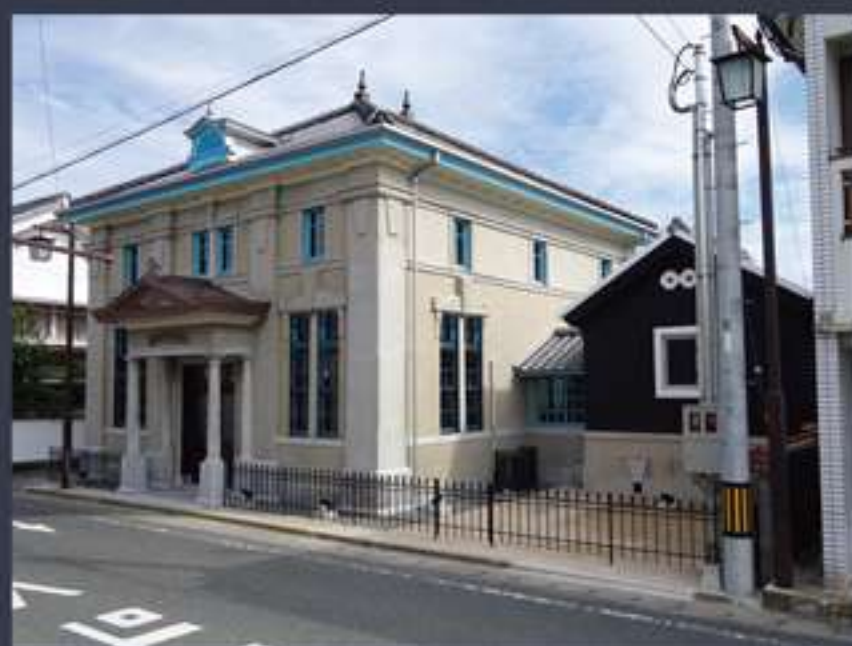
旧古賀銀行神埼支店復元工事（JV）
