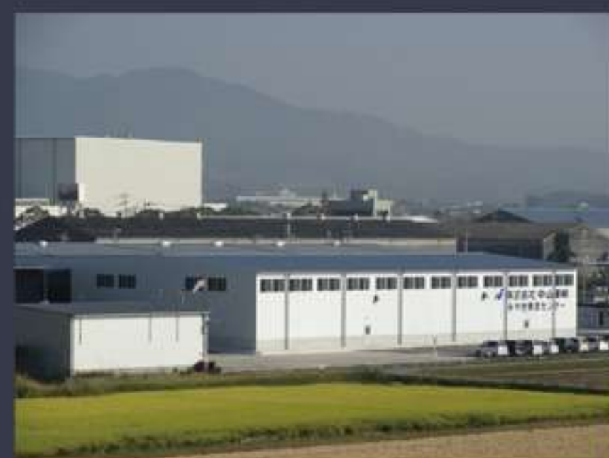
(株)中山運送みやき物流倉庫新築工事
