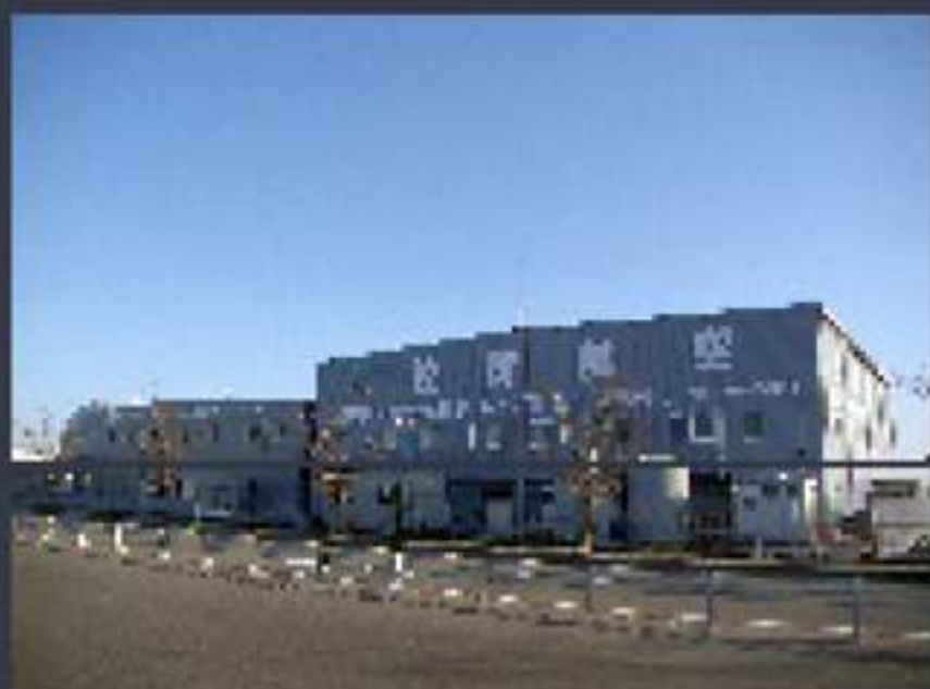
SGC 佐賀航空(株) 佐賀空港第1・第2 格納庫新築工事
