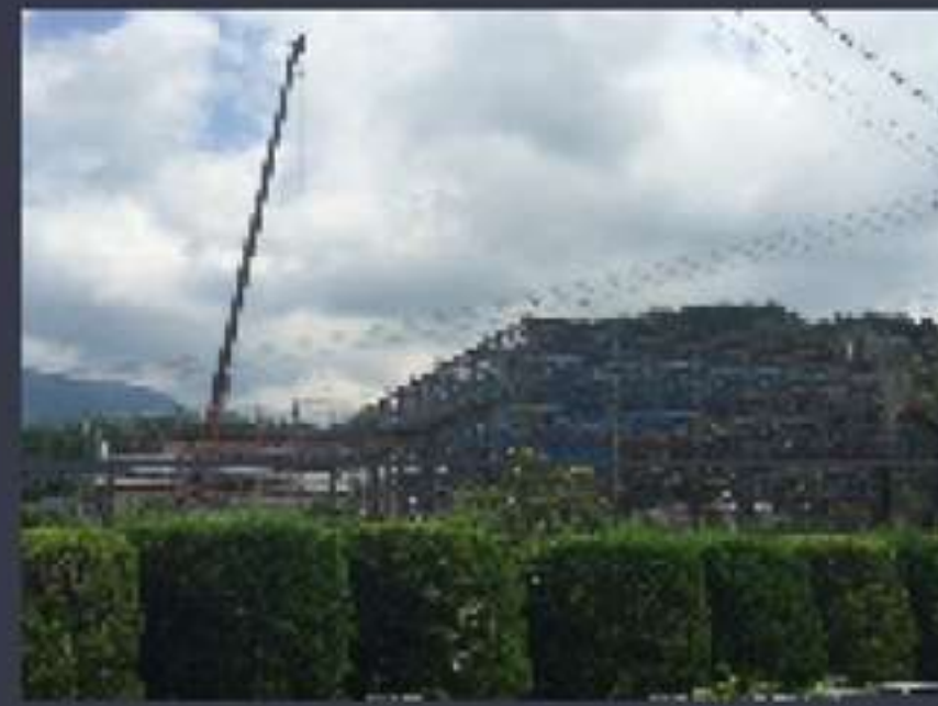
ミナノ精工(株) 唐津事業場新築工事
