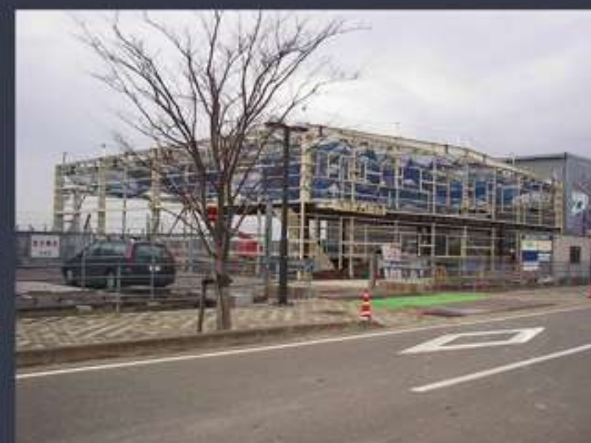
SGC 佐賀航空(株) 格納庫新築工事
