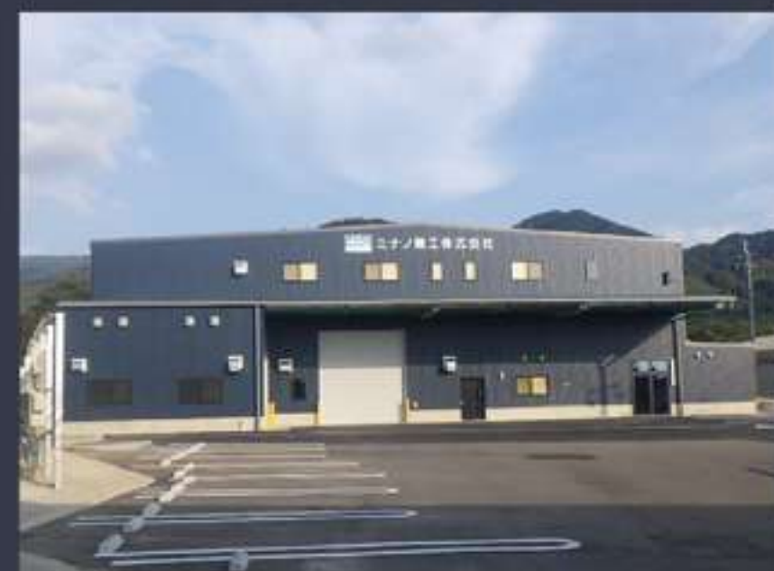
ミナノ精工(株) 本社工場新築工事
