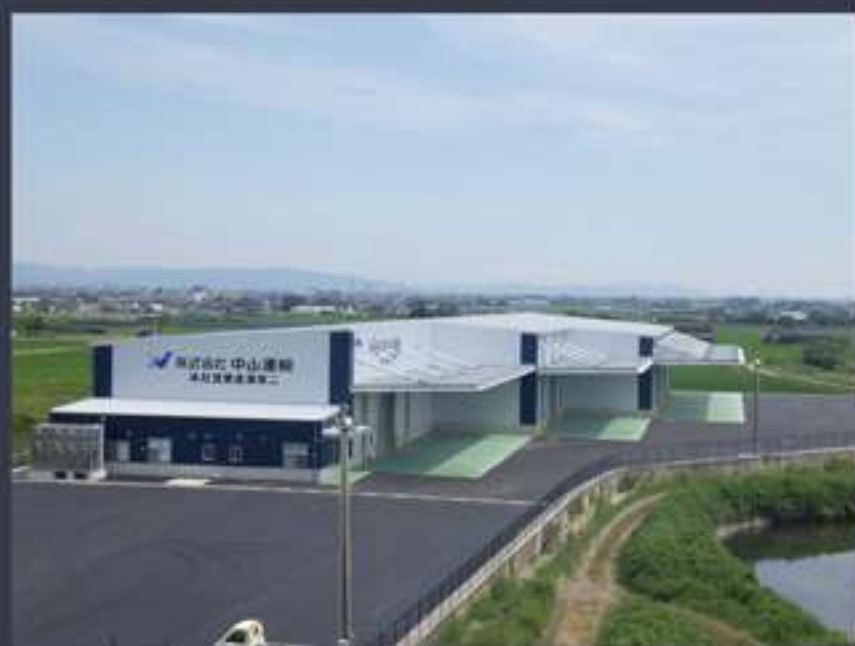
(株)中山運送 本社営業第2 倉庫新築工事
