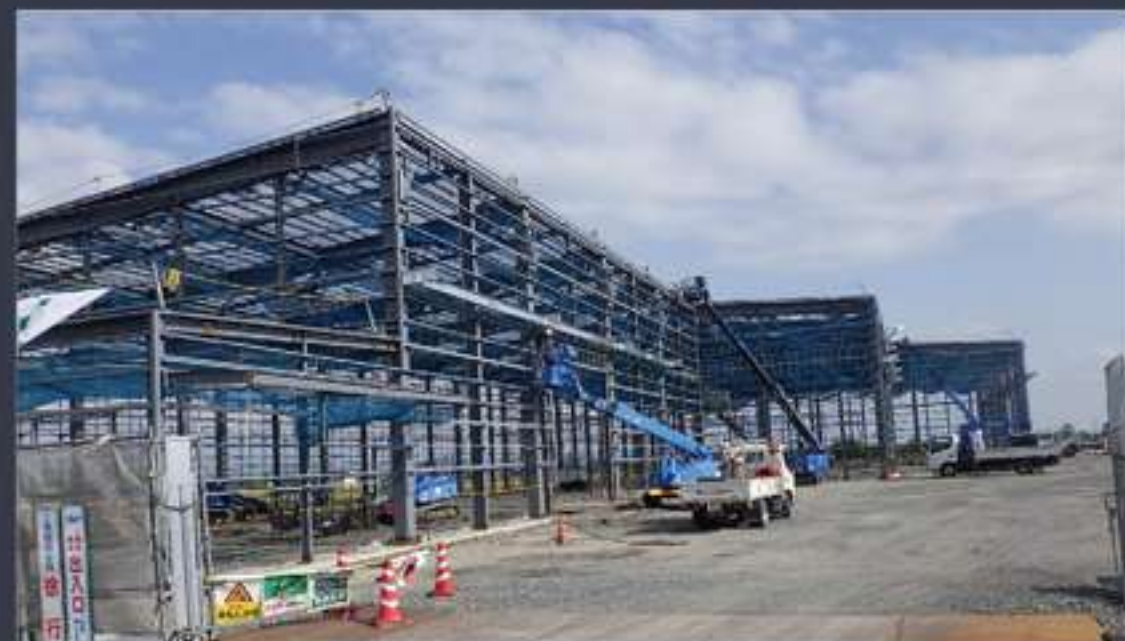
(株)中山運送 本社営業第2倉庫新築工事
