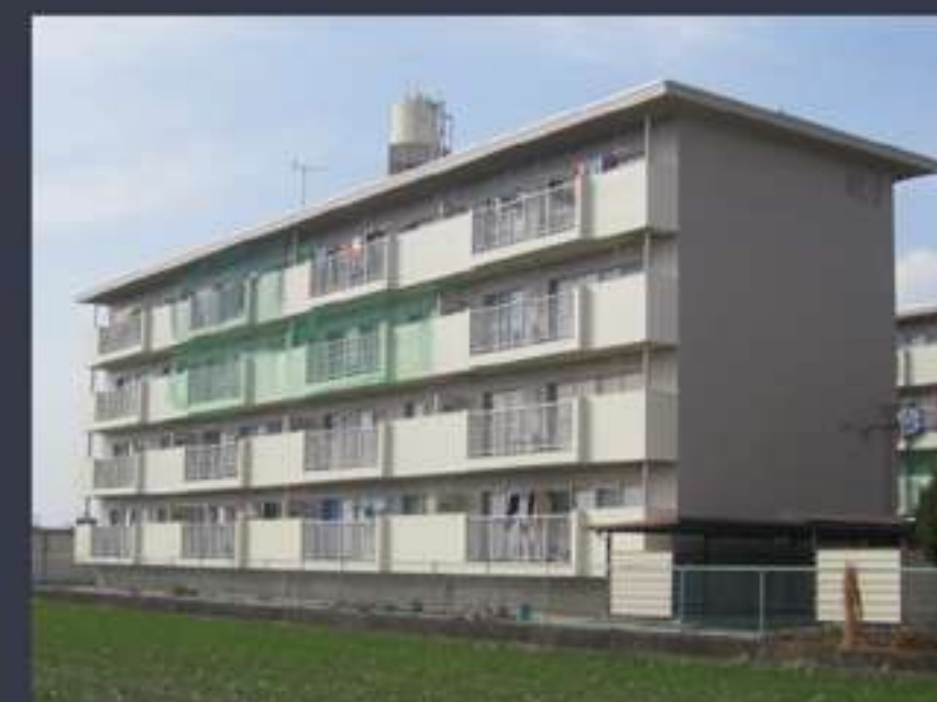
神崎市 市営東野ヶ里団地外壁等改修工事
