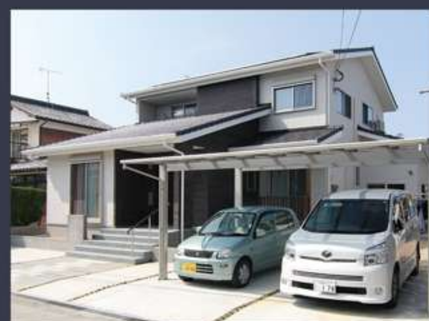
H 邸 新築工事
