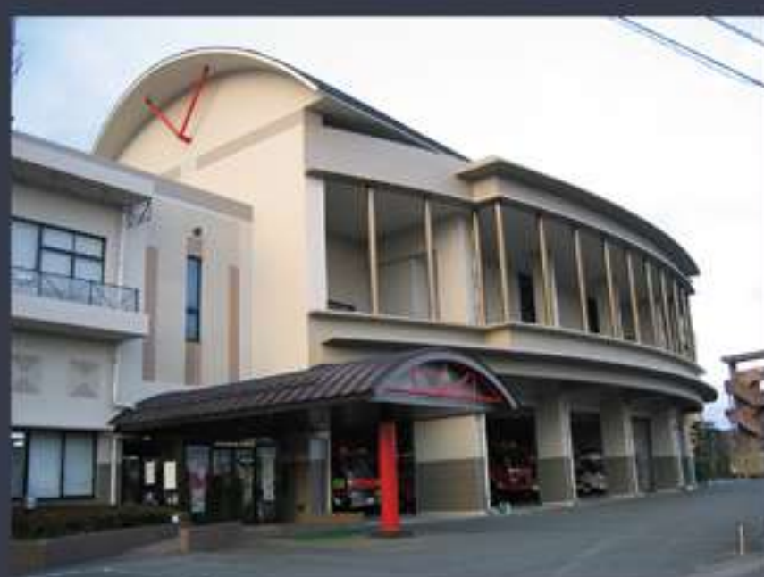
神埼消防署 改修（塗装）工事
