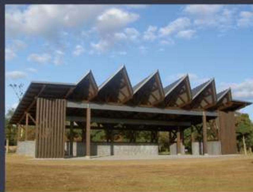
吉野ヶ里歴史公園 休憩所 新築工事
