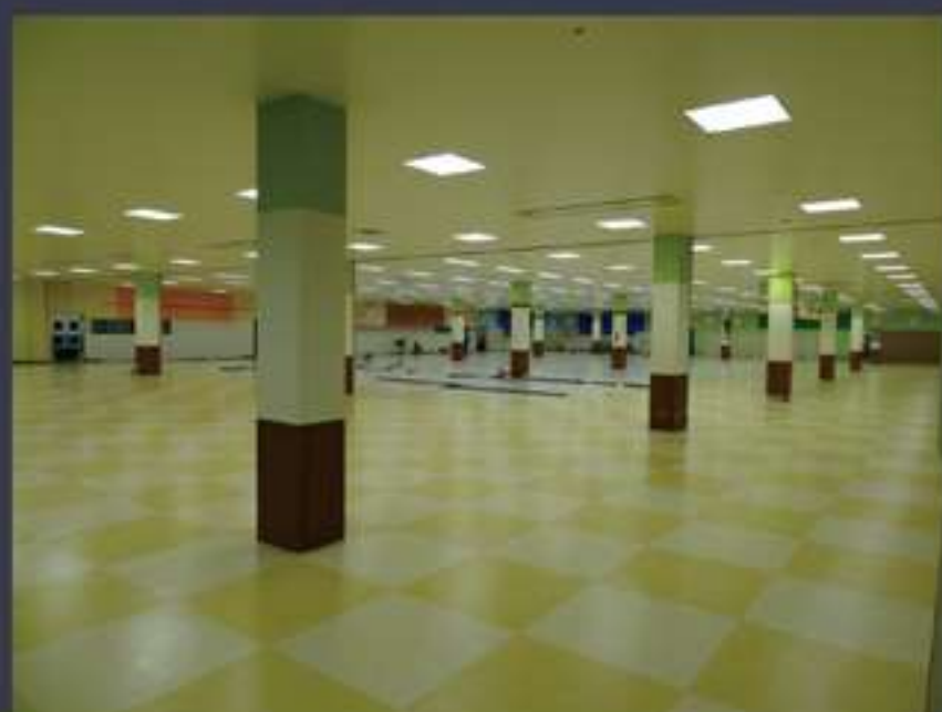
スーパーモリナガ 店舗 改修工事
