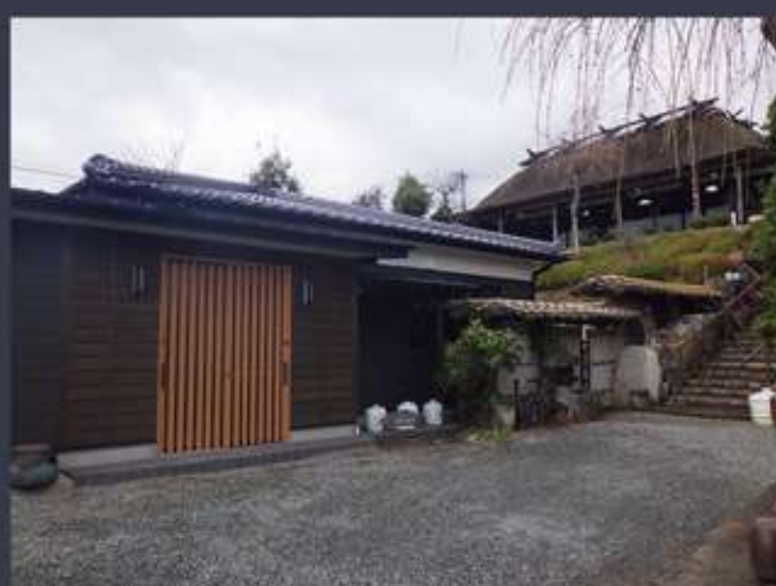
大幸園 古民家宿泊施設 改修工事
