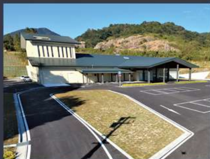
神崎市・吉野ヶ里町葬祭組合「和の社」 新築工事（JV）
